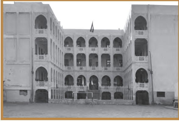
مبنى المدرسة من الداخل .
